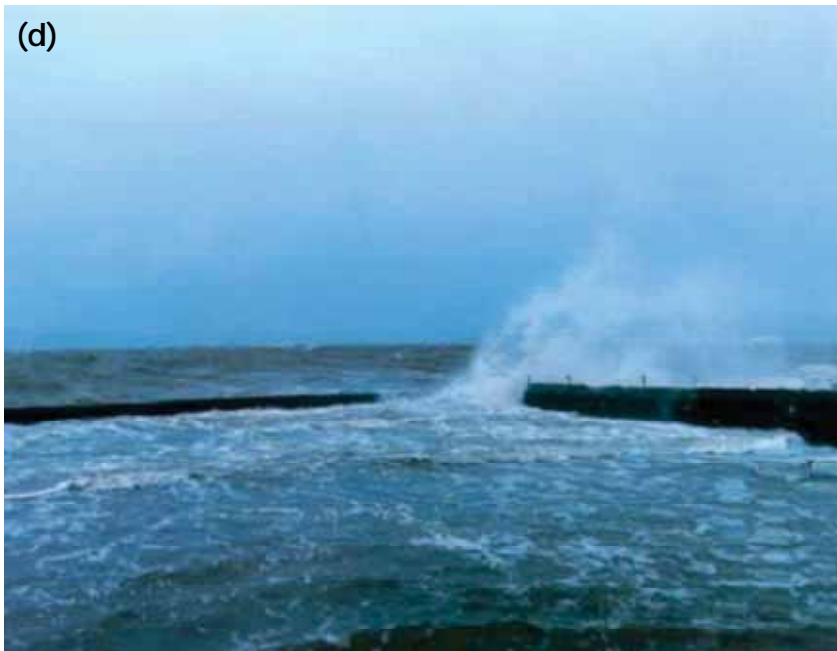
(d) Flooding of property at bottom of Adelaide Street
